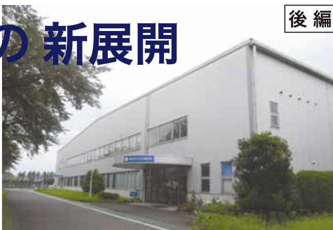
▲前橋工場の概要：(敷地面積)約185,968㎡(日新電機前橋製作所敷地内)(操業開始)2005年11月(従業員数)30名
